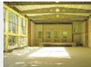
Beginn der Baumaßnahmen
